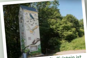
Der Turm in Bad Staffelstein ist mit einer insekten- und fledermausfreundlichen Beleuchtung ausgestattet.
