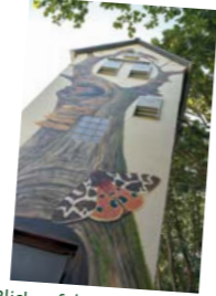
Blick auf den Trafoturm bei Vierzehnheiligen. Erstmals mit einer Fledermausthermokammer in Satteldachform.
